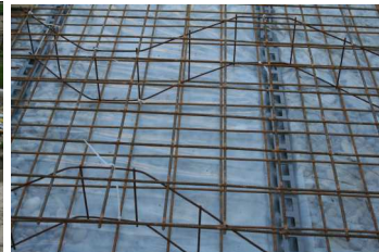
Bildfolge: Symbolfotos Rollierung, Abstandhalter Betonsohle mit Baustahlmatten 2 lagig!
