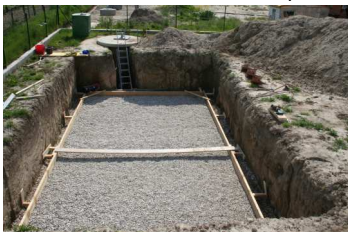
Bildfolge: Symbolfotos Rollierung, Abstandhalter Betonsohle mit Baustahlmatten 2 lagig!
