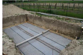
Bildfolge: Symbolfotos Rollierung, Abstandhalter Betonsohle mit Baustahlmatten 2 lagig!
