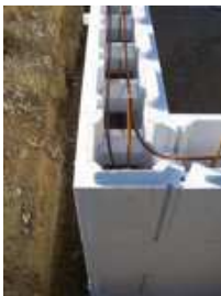
Stehende Moniereisen, Ringeisen als Stahlbewehrung! Akzentthermobecken mit eingebundener Rämertreppe
